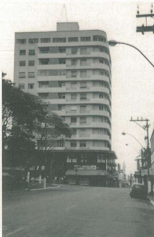
Fig. 1 Edifício Abdo Najar, com seus quebra-sóis (brises)
