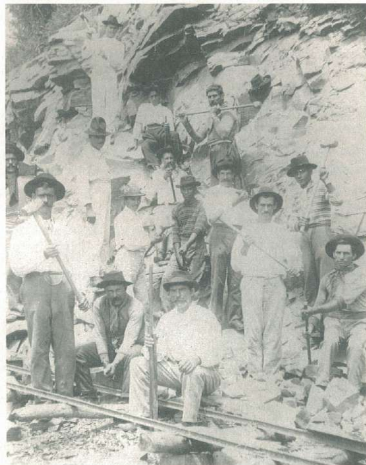
Construção da Usina Hidroelétrica de Cariobinha, década de 1930
