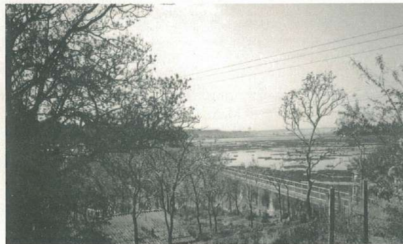
Represa de Americana - Barragem da Usina Hidroelétrica
