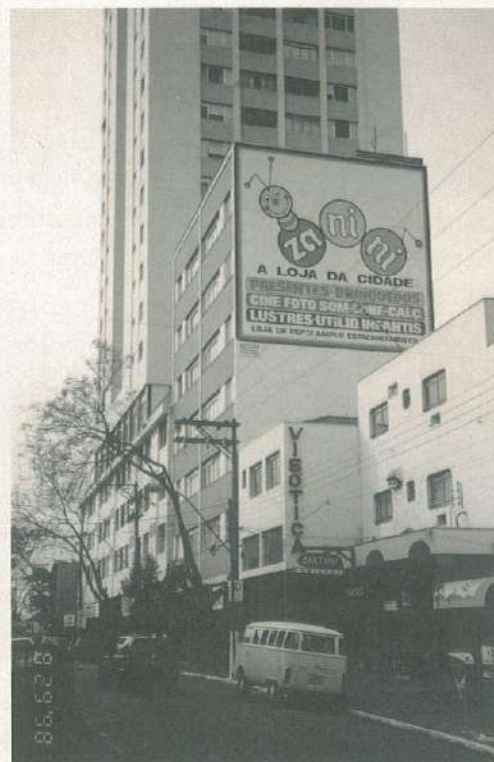
Fig. 12 Em primeiro plano, o Edifício Rosa Coronelli, com sua fachada de tijolos cerâmicos, e ao lado, o Edifício Amina Najar, com seus pavimentos inferiores diferenciados para ocupação comercial e de serviços, e logo acima a torre de apartamentos. Ambos os térreos em forma de galeria. Datados da década de 60
