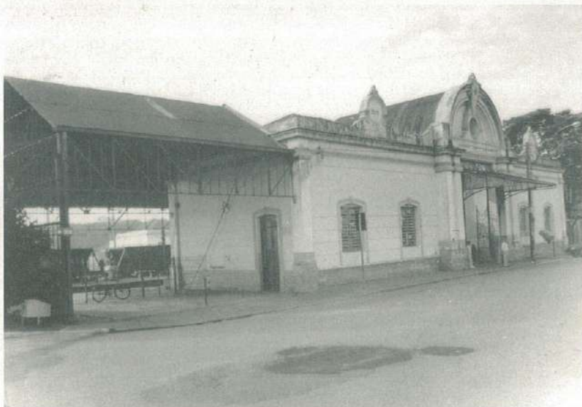
Estação Ferroviária - fachada, 1994
