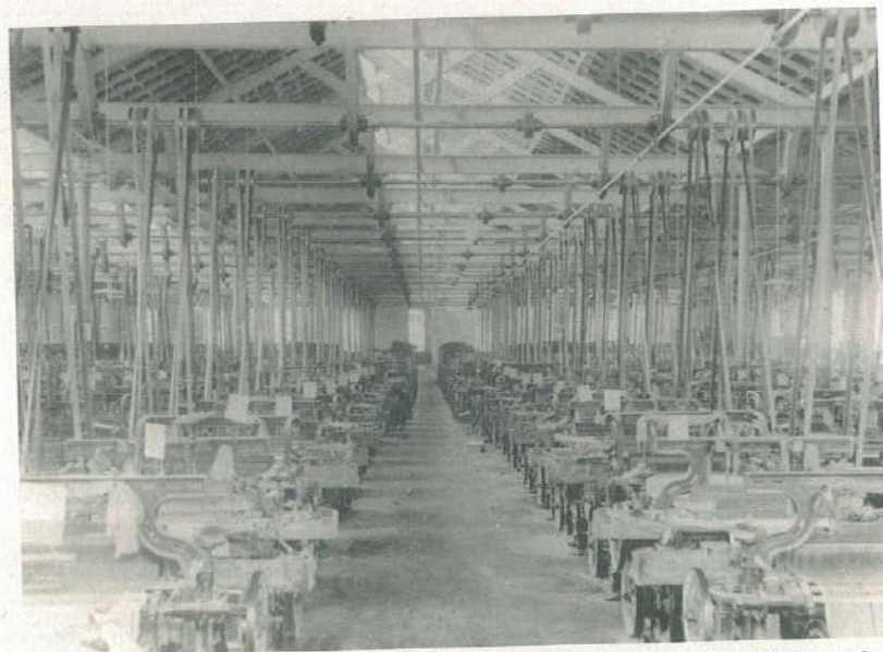
Interior da Fábrica de Tecidos Carioba
