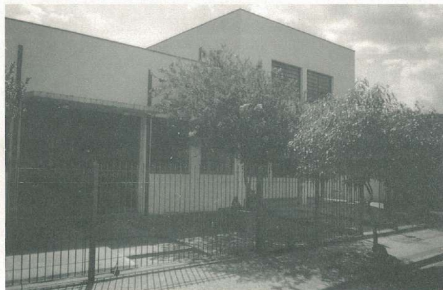
Sede atual da "Sociedade Mútuo Socorro" - rua Tarquino Benencase
