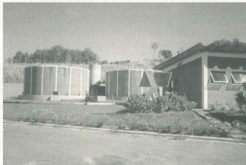
Estação de Tratamento de Esgoto de Americana - E.T.E.A
