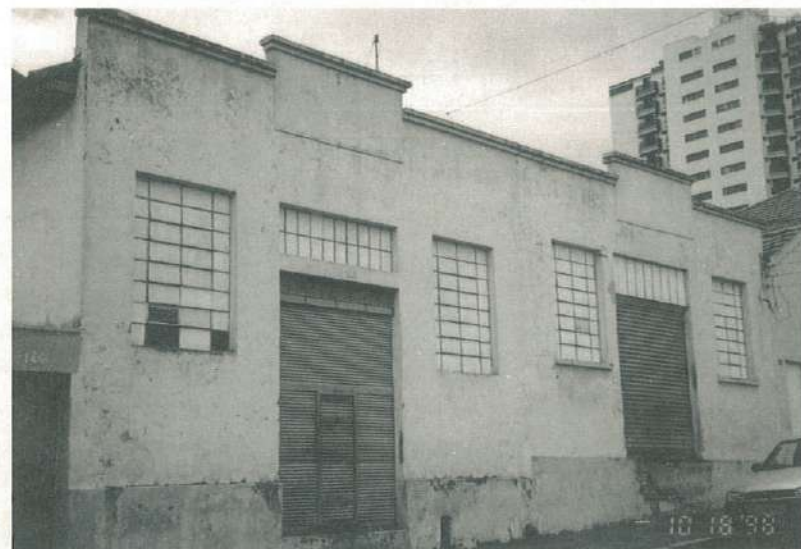
Tecelagem São Lucas - rua Dr. Cícero Jones - a permanência da atividade têxtil
