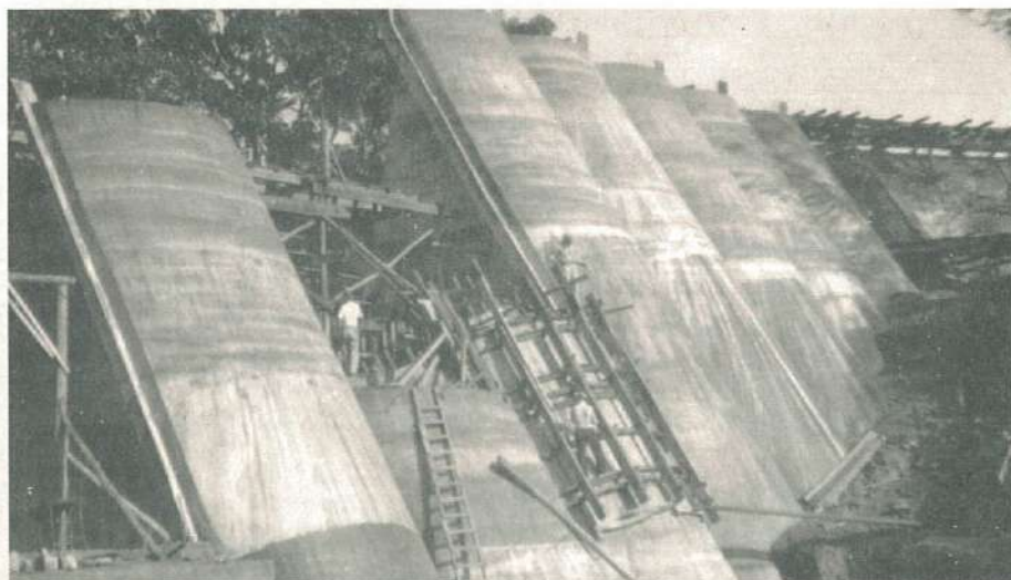
Construção da Usina Hidroelétrica
